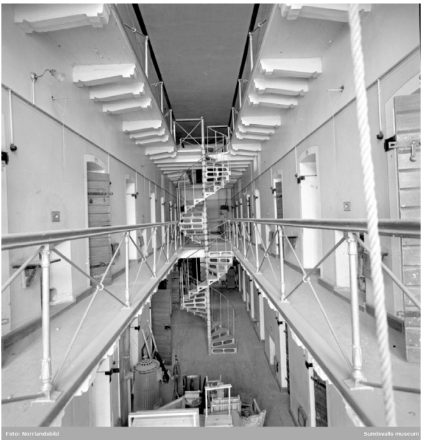
Cellerna var cirka 2 x 3 meter stora. De var placerade längs ytterväggarna i byggnaden med loftgångar och ett tre våningars schakt i mitten.
